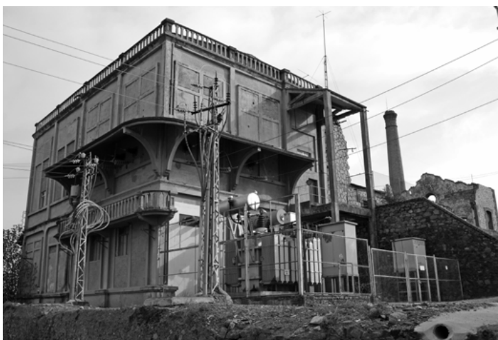
Figura 2: Subestación eléctrica (1918) y restos de la central térmica del Soldado (1908)
